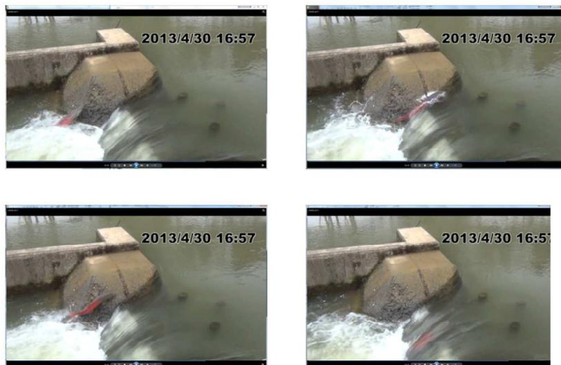
非常に多くのイトウが遡上する狩別川ですが、魚道は水流が集中しきわめて流速が激しく、依然としてイトウにとってはそれを乗り越えることが大きな障壁となっています。特に大型の個体ほどここを通過するのに失敗を何度も繰り返し、体力を消耗しているようです。落差を低減し、流水がコンクリ壁から剥離しないようにするなど、なんらかの改良工事が必要です。
